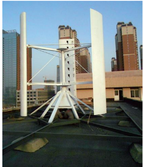
Bsp: Dachmontage auf Hochhaus
